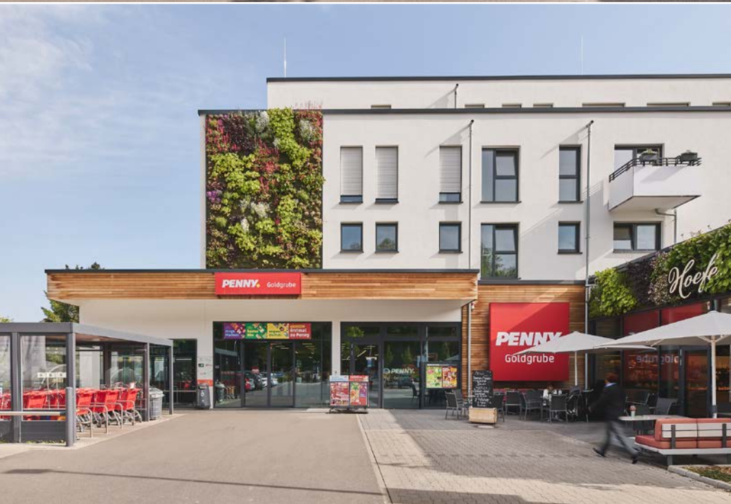
Die großflächig eingesetzten Fassadenbegrünungen sind mit einem Bewässerungssystem ausgestattet.
