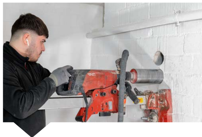
Präzise bohrt das Gerät zwei Kernbohrungen in die Außenwand des Hauses.
