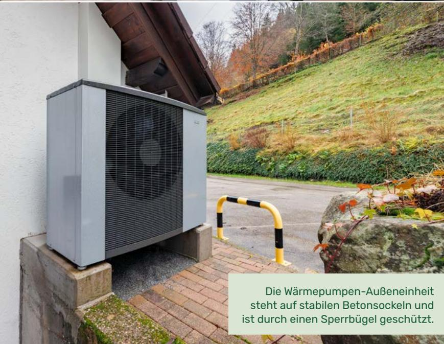
Die Wärmepumpen-Außeneinheit steht auf stabilen Betonsockeln und ist durch einen Sperrbügel geschützt.
