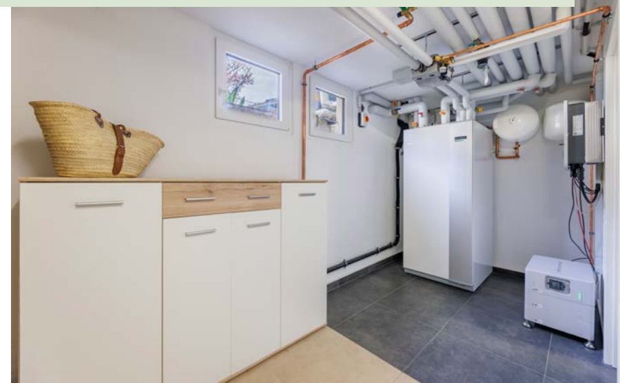
Kompakter geht es kaum – in der Inneneinheit VVM 500 ist ein Solarthermie-Wärmetauscher samt hygienischer Brauchwasserbereitung integriert.
