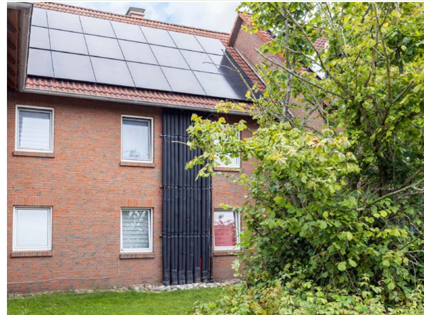
Die Vor- und Rücklaufleitungen zwischen den Außeneinheiten und den Speichern im Obergeschoss der Gebäude wurden an der Fassade verlegt – hier wird noch eine Verkleidung für eine ansprechende Optik sorgen.
