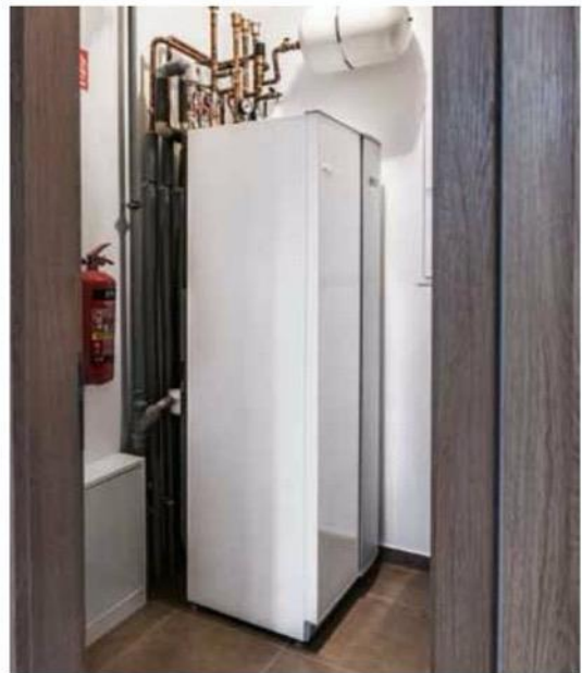
Vnitřní systémová jednotka VVM 320 s vestavěným ohřivačem vody a doplňkovým zdrojem tepla (elektrokotlem)
