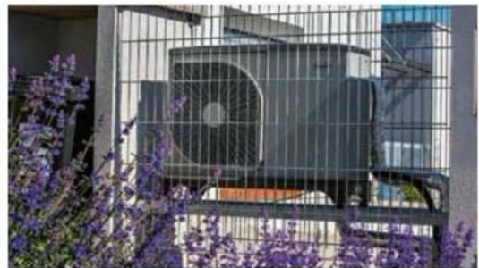
Venkovní jednotka tepelného čerpadla systému vzduch-voda NIBE F2040-6
