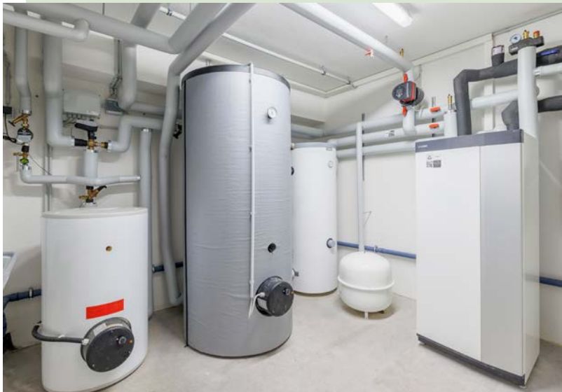
Das Brauchwasserkonzept mit der Vorwärmstufe (grauer Speicher) und der als „Booster“ eingesetzten Nachwärmstufe (weißer Speicher) links daneben.
