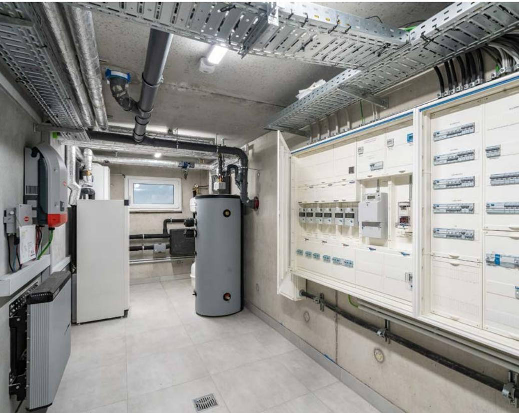
Wärmepumpe, Wechselrichter, Pufferspeicher und Zählerkasten sind kompakt im Hauswirtschaftsraum angeordnet.
