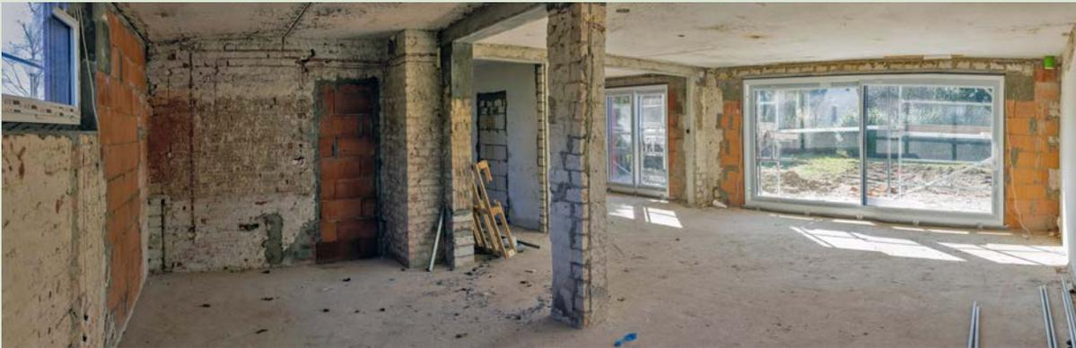
Vollständig entkernt – das Haus wurde bis auf die Grundmauern zurückgebaut und erweitert, dabei wurde die Haustechnik umfassend modernisiert.
