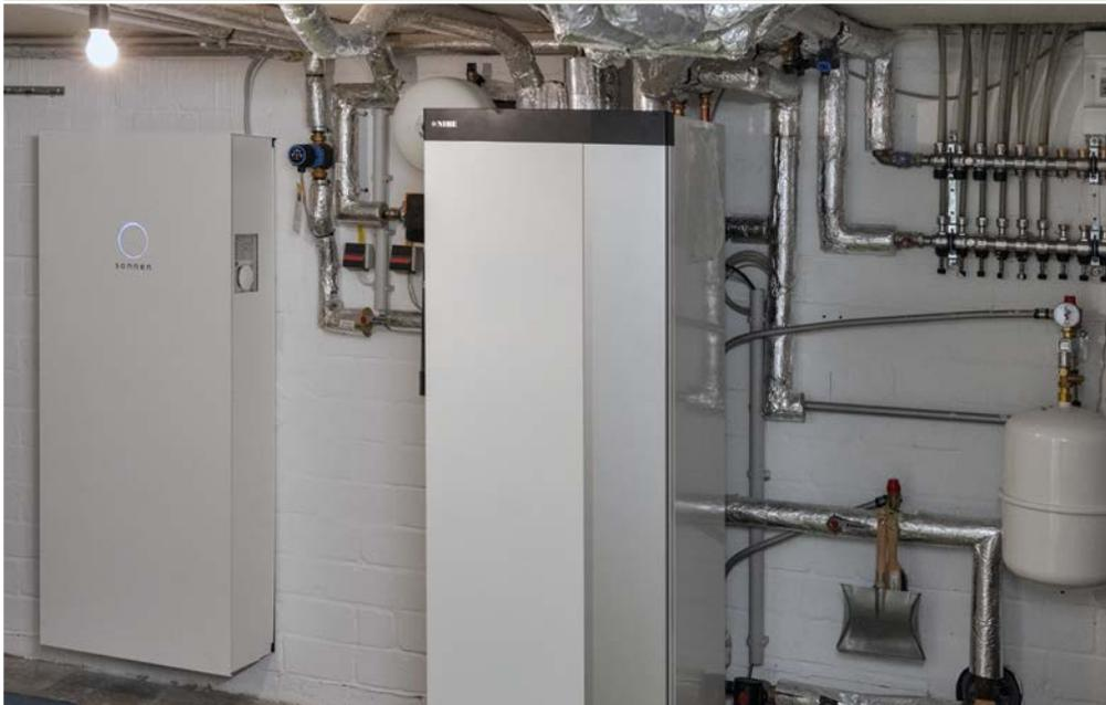
Saubere Sache: Die Inneneinheit des Wärmepumpensystems steht zusammen mit dem Elektro-speicher und den Zählerkästen im Technikeller.
