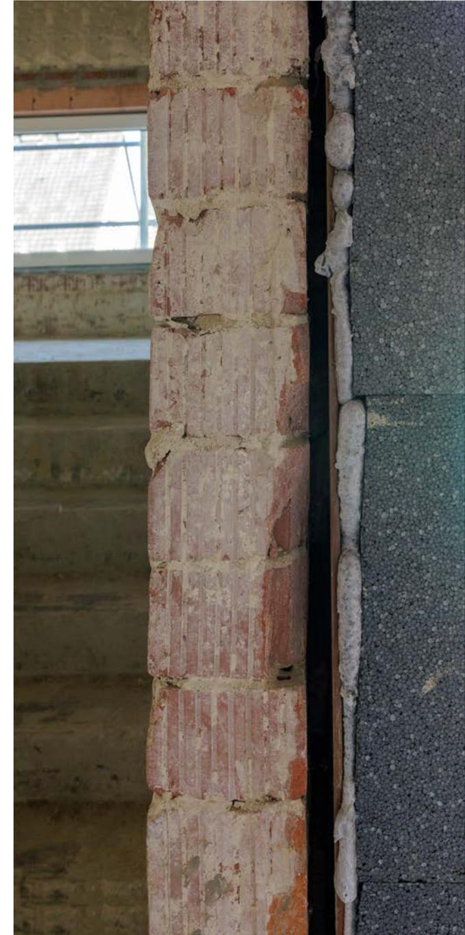
Sanierung at its Best: Die Außenwände werden mit einem massiven Wärmedämm-Verbundsystem isoliert.
