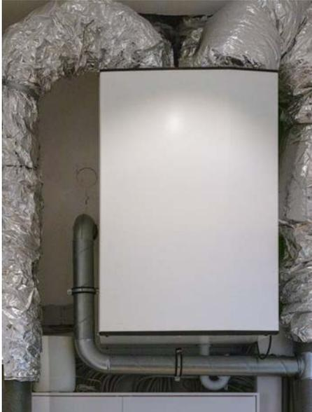
Das ERS Lüftungsmodul mit Wärmerückgewinnung befindet sich im Obergeschoss – die Technik wurde später mit einem Einbauschränk verkleidet.
