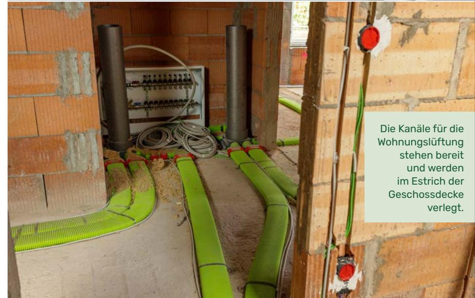
Die Kanäle für die Wohnungslüftung stehen bereit und werden im Estrich der Geschosdecke verlegt.
