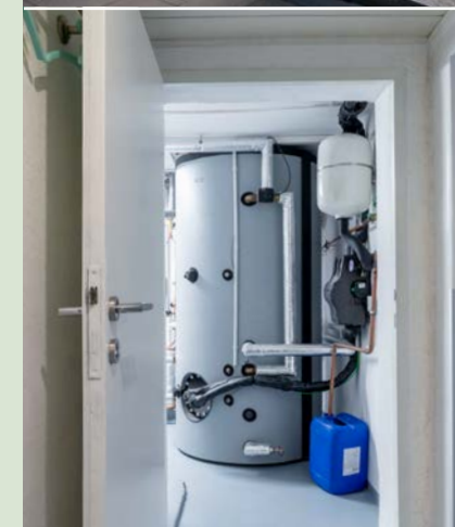
Enge Kiste: Der große Wasserspeicher wurde in Millimeterarbeit in den Heizungskeller bugsiiert.
