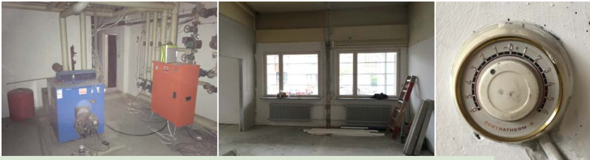
Technik aus dem letzten Jahrtausend: Die alte Ölheizung wurde ausgebaut und entsorgt.
