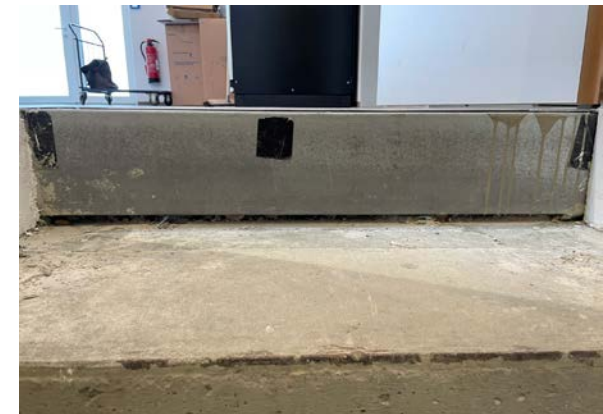
An der obersten Stufe der Kellertreppe ist der neue Estrich gut erkennbar.
