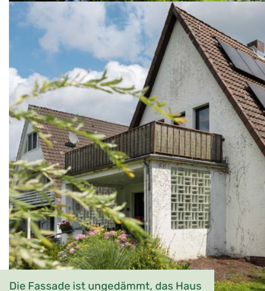
Die Fassade ist ungedämmt, das Haus befindet sich energetisch weitgehend im Originalzustand von 1962.
