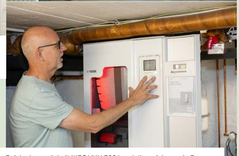
Bei der Inneneinheit NIBE VVM 320 handelt es sich um ein Demogerät, das bei Messen und Ausstellungen eingesetzt wurde; daher ist die Front teilweise transparent.
