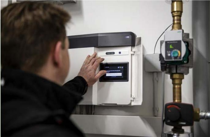
Die Wärmepumpe lässt sich einfach über das integrierte Display der Regeleinheit einstellen.
