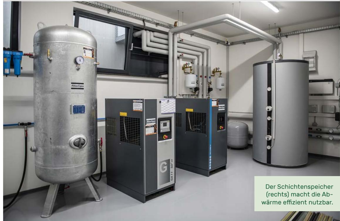
Der Schichtenspeicher (rechts) macht die Abwärme effizient nutzbar.
