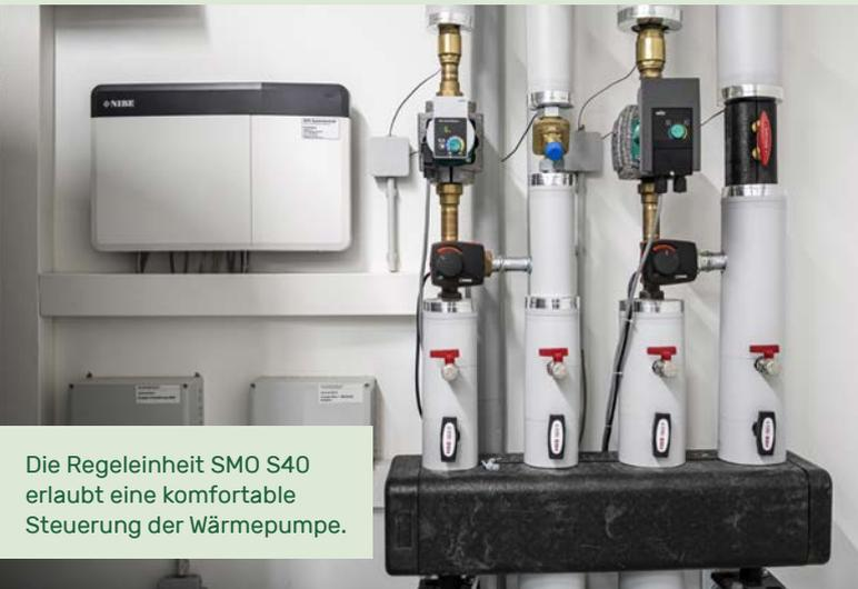
Die Regeleinheit SMO S40 erlaubt eine komfortable Steuerung der Wärmepumpe.
