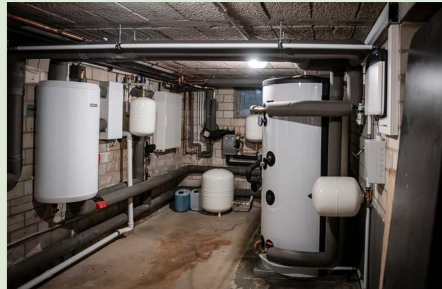
Im Keller befinden sich anstelle der alten Öltanks nun die Steuerung für die Wärmepumpe, der Schaltschrank für die PV-Anlage und die Speicher für die Brauchwasserversorgung.
