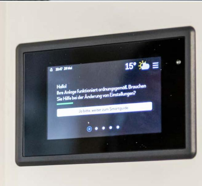
Der Bauherr ist rundum zufrieden: Nach einer kurzer Einführung ist die Bedienung der Wärmepumpe völlig unkompliziert. Die intelligente Steuerung SMO S40 lernt automatisch dazu und passt sowohl die Heizkurve der Anlage als auch die Warmwasserbereitung dem Nutzungsverhalten der Bewohner an.
