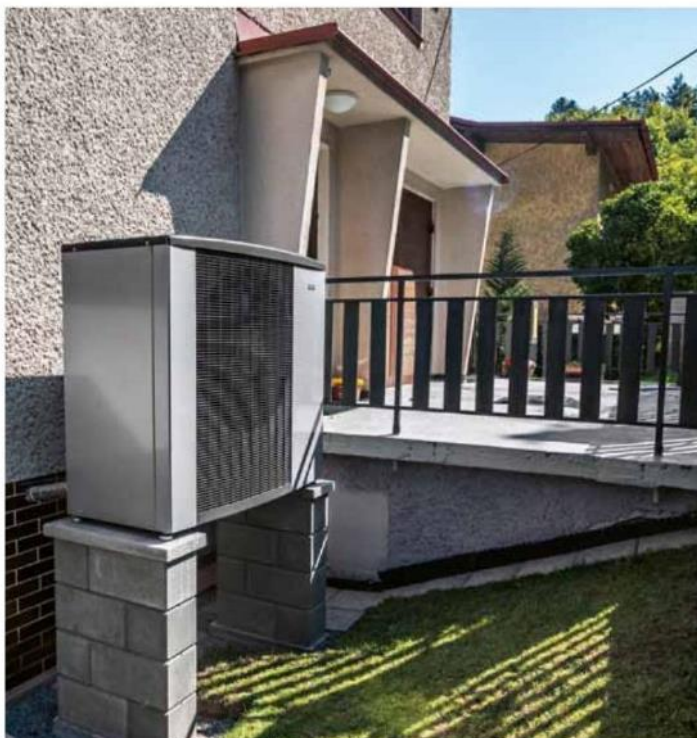
Tepelné čerpadlo vzduch-voda NIBE F2120-16 s řízeným výkonem kompresoru
