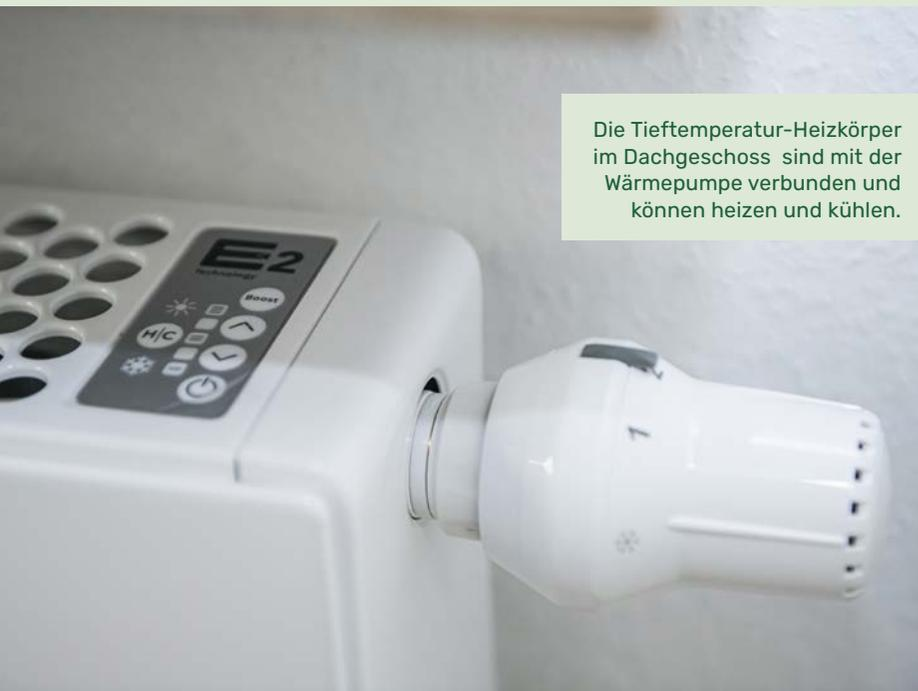
Die Tieftemperatur-Heizkörper im Dachgeschoss sind mit der Wärmepumpe verbunden und können heizen und kühlen.
