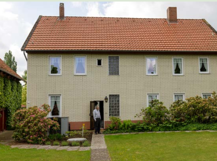
Die Rückseite des Hauses enthält statt des Fachwerks gemauerte Steine.
