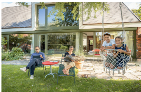
Das Einfamilienhaus wurde saniert mit einer Nibe Sole/Wasser-Wärmepumpe «S1255» mit integriertem Brauchwarmwasserspeicher von 180 Liter.
