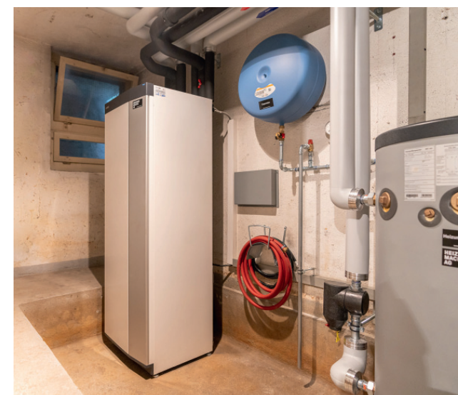
Die neue Sole/Wasser-Wärmepumpe «S1255» braucht nicht viel Platz im Keller.
