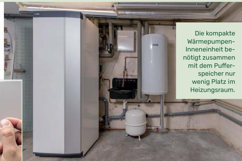
Die kompakte Wärmepumpen-Inneneinheit benötigt zusammen mit dem Pufferspeicher nur wenig Platz im Heizungsraum.
