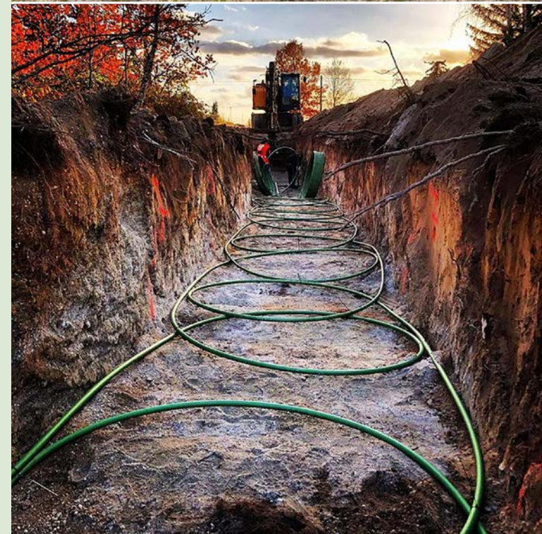
Wärme aus der Erde: Der Ringgraben verläuft um das Grundstück und das schlaufenförmig verlegte PE-Rohr nimmt die Erdwärme auf.
